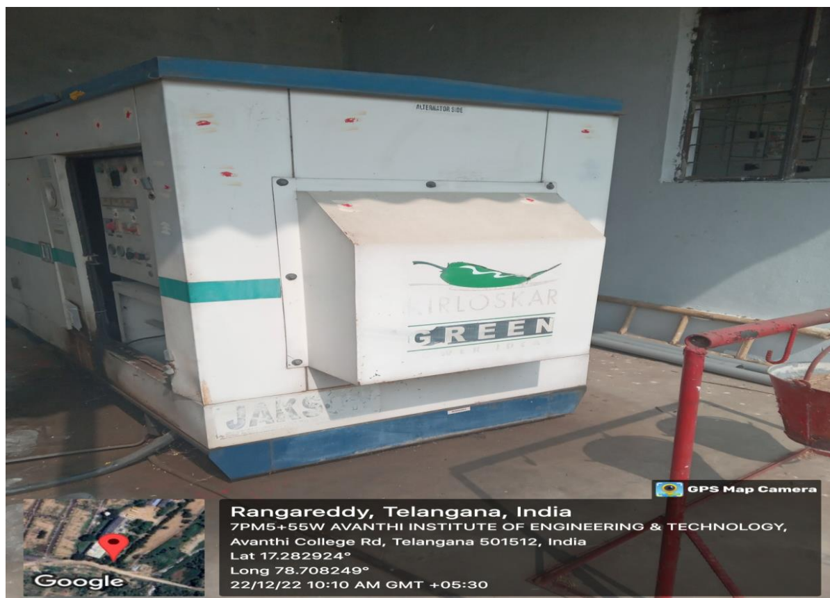
Fig.9: DG-SET 62.5KVA
